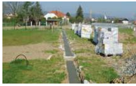
1. Betondichtschlämme gegen aufsteigende Feuchtigkeit
