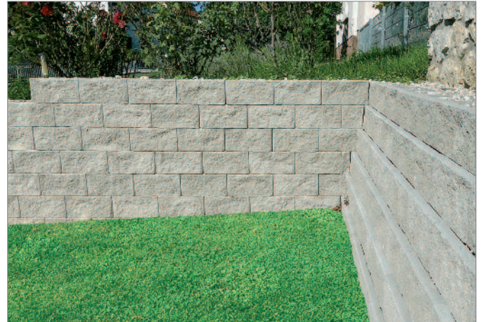
Bild 2: Gerade und versetzte Wände mit Böschungssteinen
