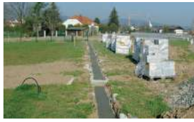
1. Betondichtschlämme gegen aufsteigende Feuchtigkeit
