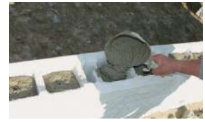
3. Füllbeton Menge des Anmachwassers laut Gebrauchsanweisung – zuviel Wasser mindert die Betonqualität. Wichtig: Füllbeton während der 28-tägigen Aushärtung vor Regen schützen!
