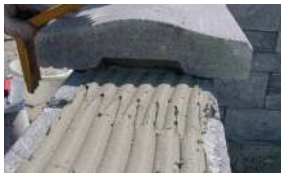
4. Dichtschlämme/ Abdeckplattenkleber mit Glättkelle mit runder Zahnung kommt es zu vollflächiger Verklebung
