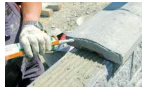
5. Montagekleber/Fugendichtmasse Jede Fuge ist eine Schwachstelle und muss daher sorgsam abgedichtet werden. Nehmen Sie sich die Zeit, es lohnt sich.
